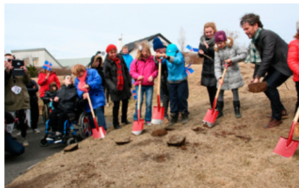
Í apríl hófust framkvæmdir við viðbyggingu og endurbætur á Klettaskóla með skóflustungum borgarstjóra og nemenda skólans.
