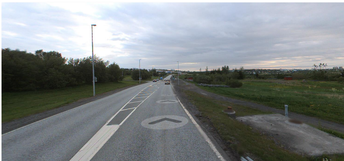
Mynd 3. Við Stekkjarbakka, horft til vesturs. ©ja.is (360°)
