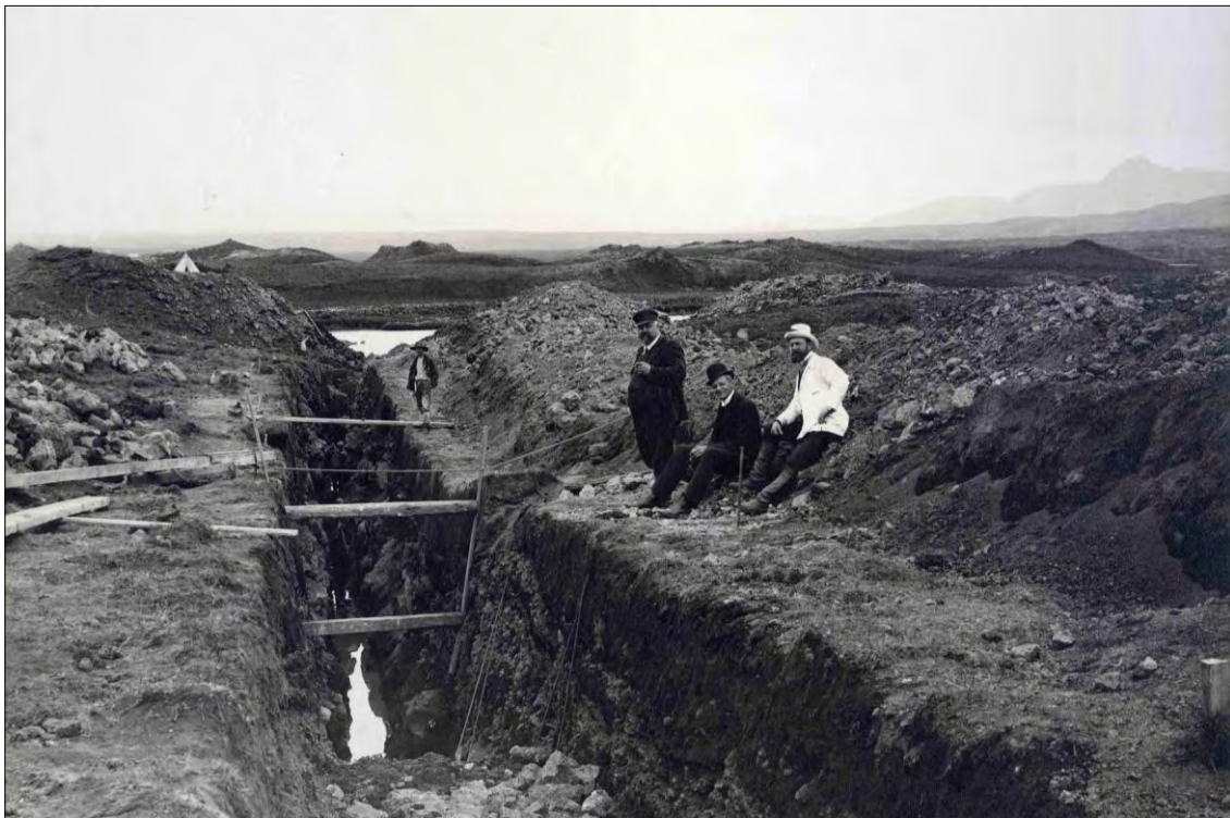
Mynd 4 Lagning vatnsveitunnar 1908 eða 1909. Yfirverkfræðingur framkvæmdanna, H.A. Hansen, stendur við skurðinn, en við hlið hans situr Knud Zimsen, þáverandi bæjarverkfræðingur Reykjavíkur. Í baksýn sjást Rauðhólar. 18
