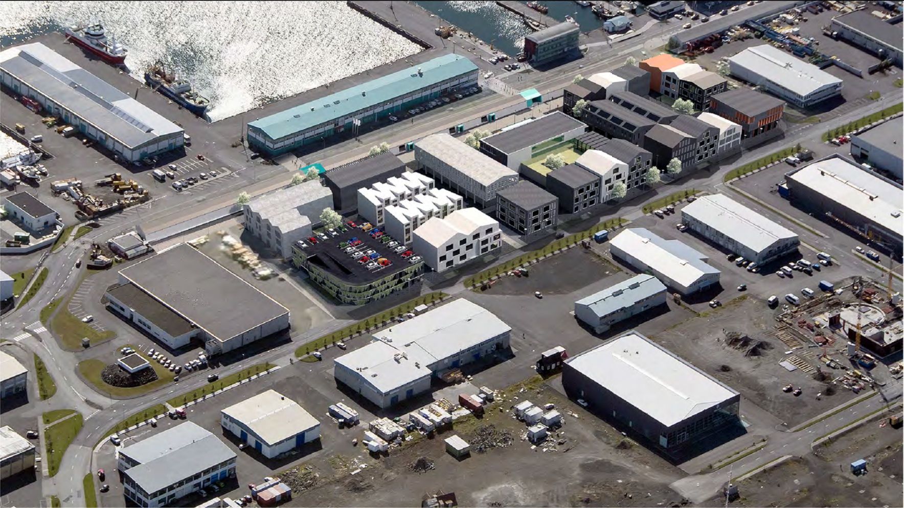
Yfirlitsmynd - horft til suðurs
