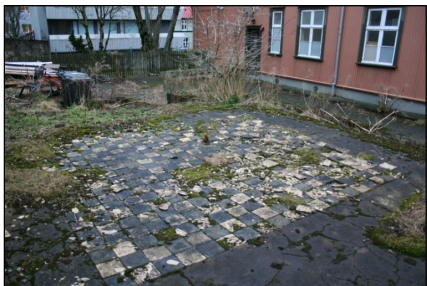
Mynd 9. Leifar af grunni og gólfplásum líkhússins (5-257) við Spítalastíg.
