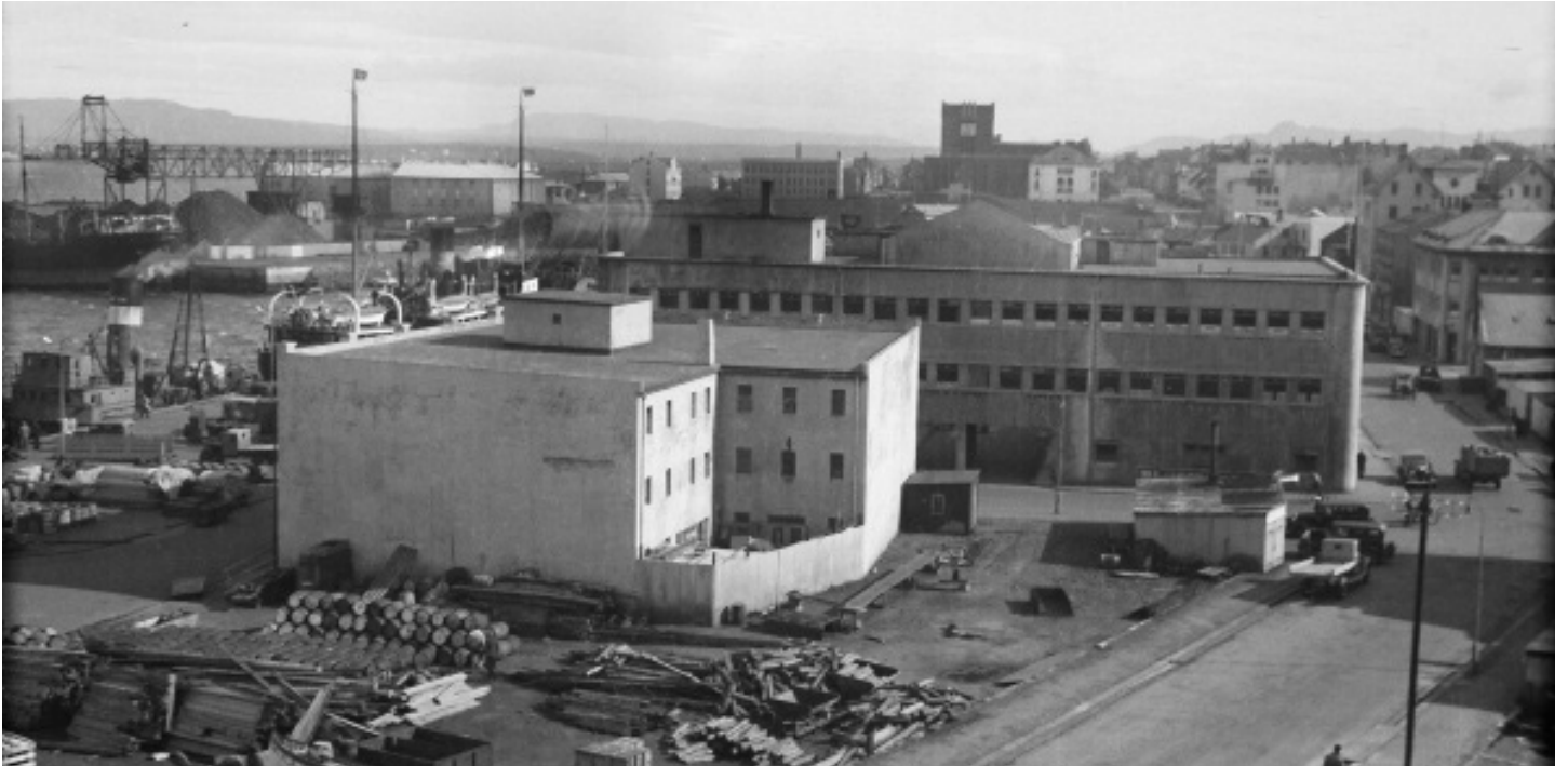
1936-1939, við Reykjavíkurhöfn Grófarhús
