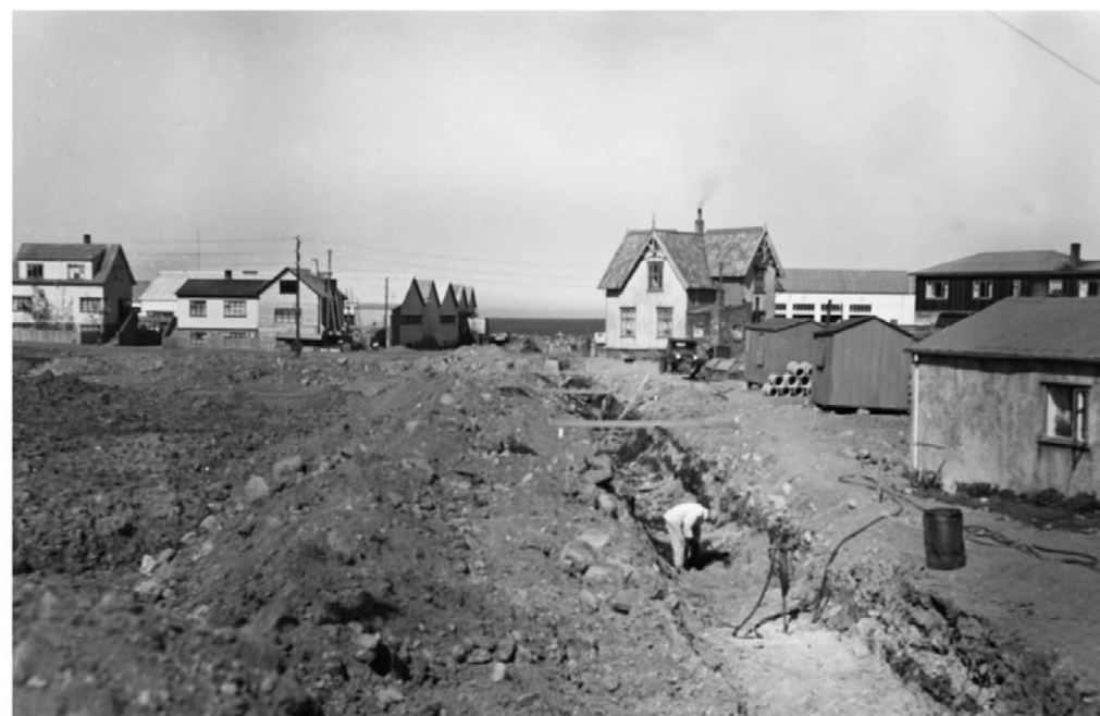
Framkvæmdir við lagningu holræsis og vegar þar sem Laugalækurinn lá áður, á ljósmynd frá um 1955. Séð í vestur í átt að Kirkjusandi og norðurenda Laugarnesvegur. T.v. má sjá húsin nr. 83 og 85 við Laugarnesveg og húsið Bjarmaland , sem stóð rétt norðan við núverandi gatnamót Laugarnesvegur og Laugalækjar. 72
