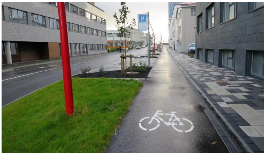
MYND 11 Hjólastígur með einstefnu aðskilinn frá göngustíg með hæðarmun. Myndin er tekin í Borgartúni. Hér mætti vera ör til að sýna einstefnu. (Mynd: Erik Kærgaard).
