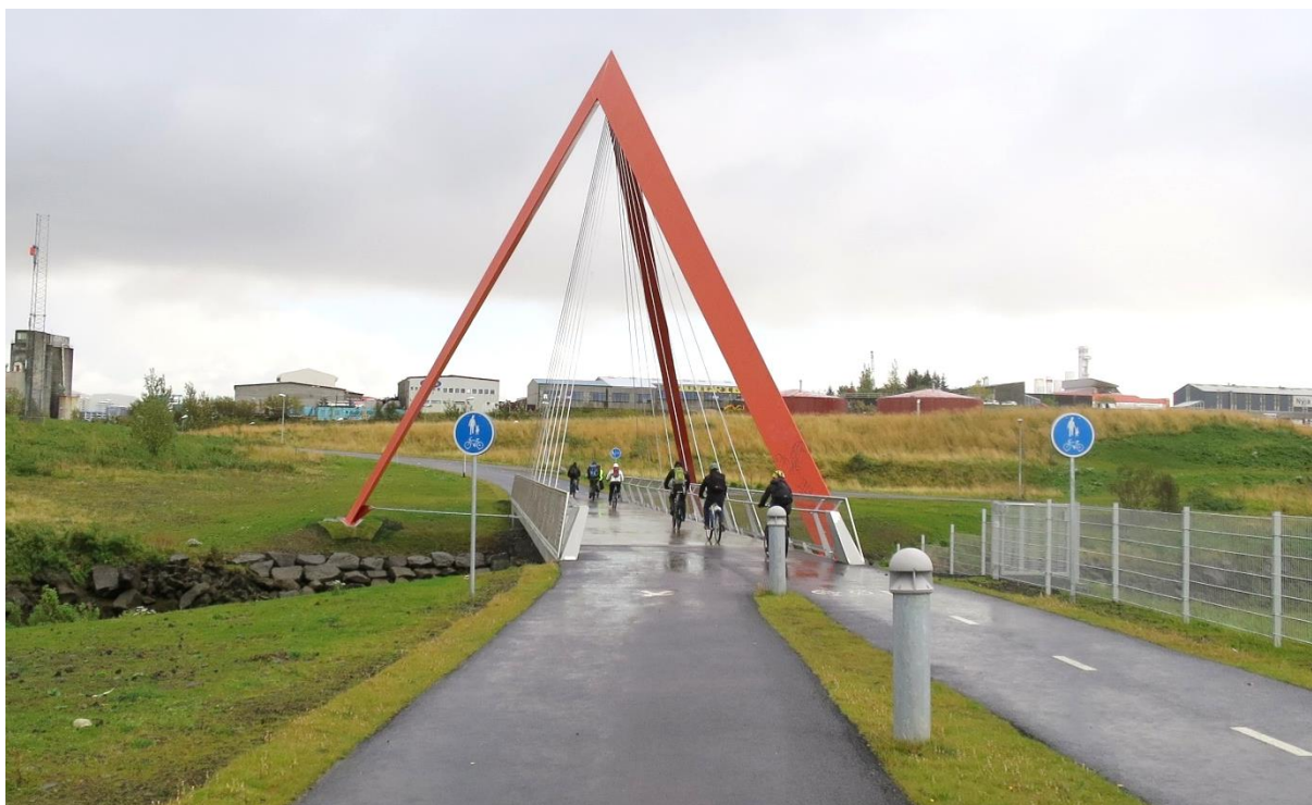
MYND 48 Óheppileg hönnun brúarhandriðs. Handrið brúar hallar inn og þrengir að rými vegfarenda. Eins geta hjólréiðamenn hjólað á handriðsenda eða framhjá því, ofan í ána. Við Elliðaárósa. (Mynd: Erik Kærsgaard)
