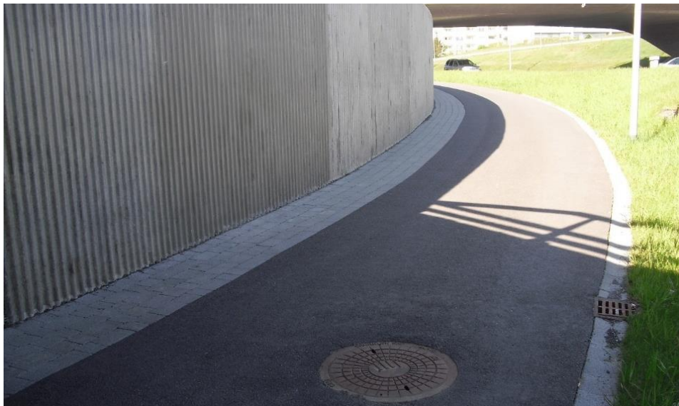
MYND 28 Sameiginlegur stígur þar sem sjónlengdir eru ekki nægjanlegar. Reykjavík við Kringlumýrarbraut.
