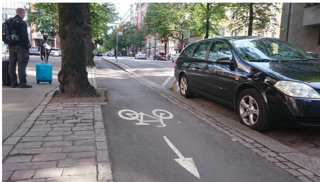
MYND 54 Hjólastígur með einstefnu við samsíða bílastæði. Öryggisræma milli bílastæðis og hjólastígs. Helsinki, Finnland.
