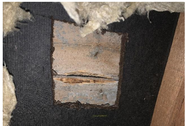
Mynd 21. Vesturland, þak. Mygla greindist í þakklæðningu sem skilin var eftir frá síðustu viðgerðum. Loftrás er úr tjörtexi.
