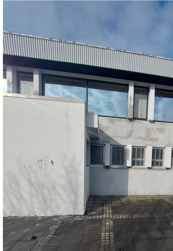
Mynd 9. Meginland, heimilisfræði 2.hæð, austurhlið
