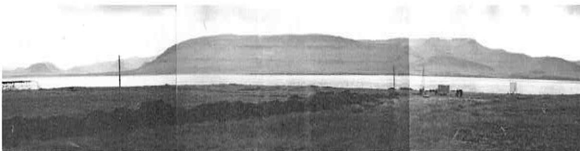
Grundartangi á áttunda áratugnum við upphaf undirbúningsframkvæmda.
