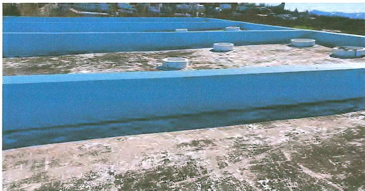
Mynd 6. Horft til norðurs eftir þaki. Bitar á þaki hafa verið klæddir af til þess að verjast skemmdum í steypu og stáli.
