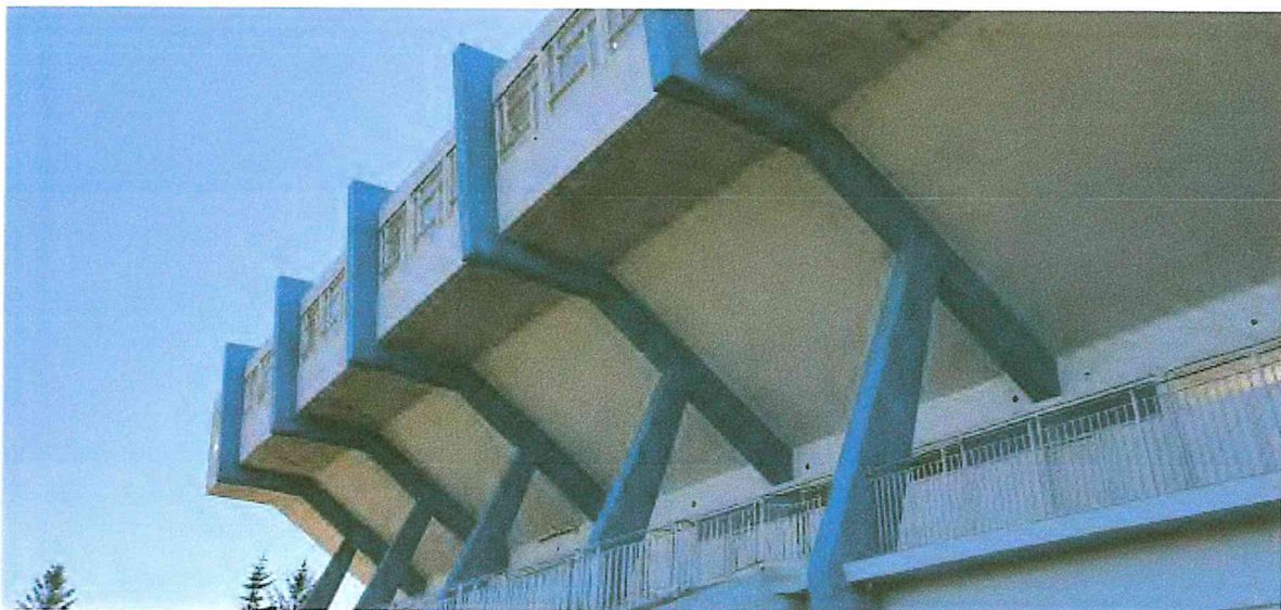
Mynd 3. Horft aftan á stúkuna vestan megin. Rammar á bakvegg eru samfelldir að efstu brún skyggis. Hér má sjá hvernig rammarnir hafa verið klæddir af á vegghlutanum til þess að verja þá gegn regnvatni.
