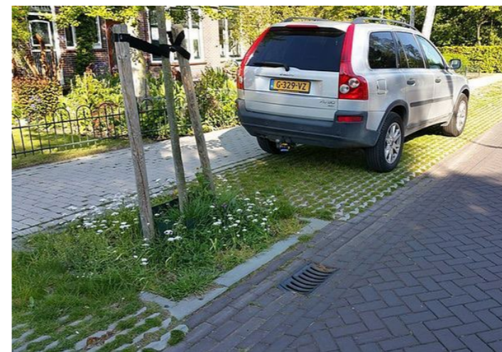
Gegndræp bílastæði meðframgötu f. gesti
