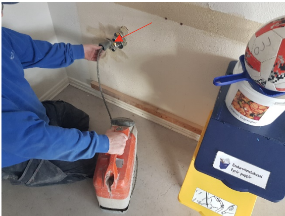
MYND 4 Vatni dælt inn á frárennslislagnir. Dælt var inn frá áfanga 2.
