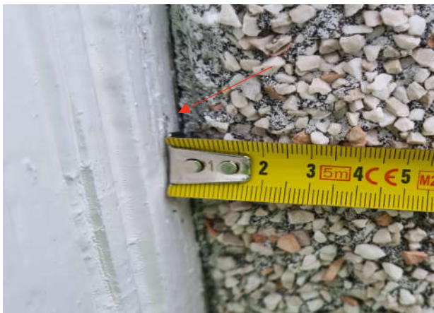
MYND 4 Rýrnun karma myndar rauf milli steins og timburs.
