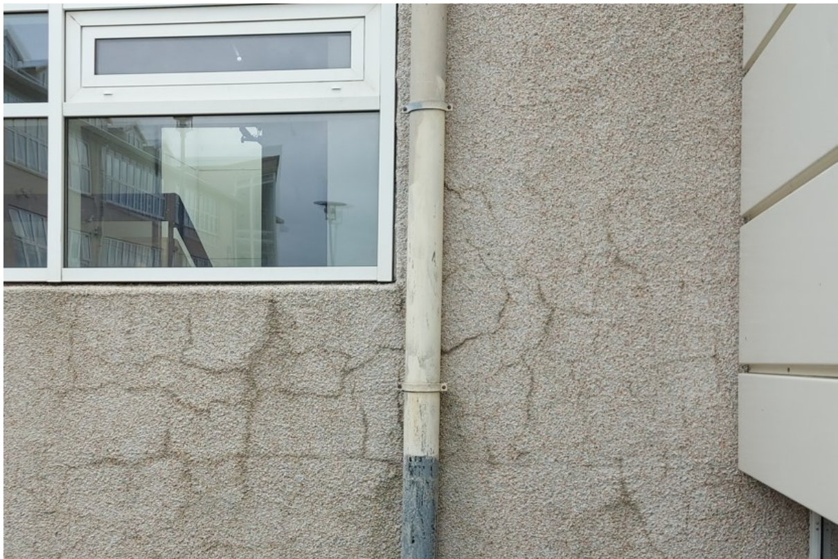
Mynd 6: Sprungunet á útvegg í vestur á C gangi þar sem raki kemst inn.
