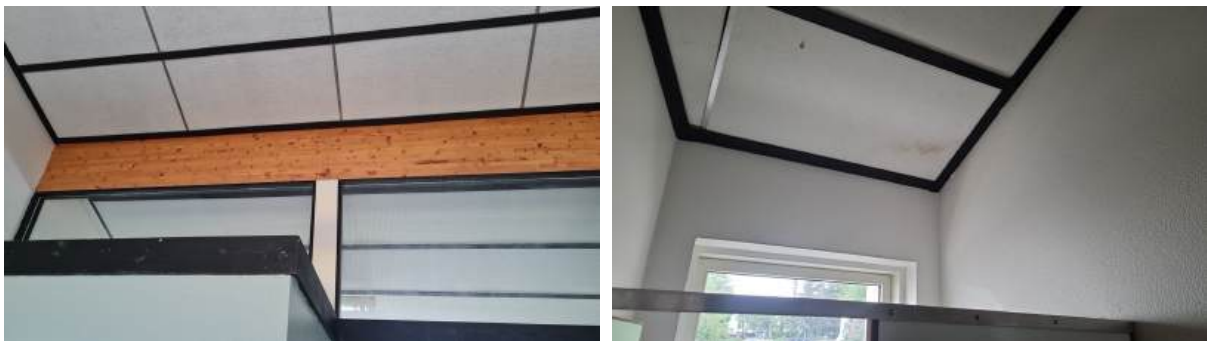
Mynd 14. Töluverð lekaummerki eru innan á þaki C-álm og slæm lykt í kennslustofum.
