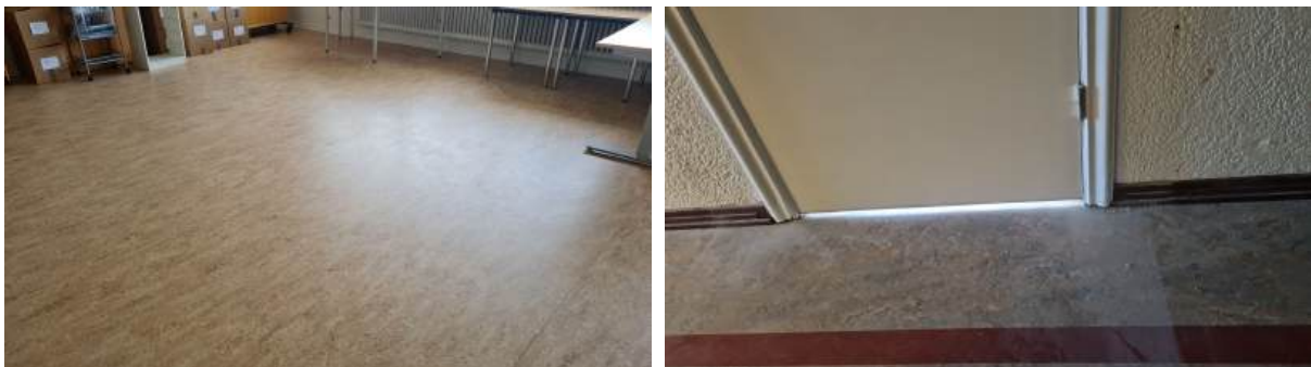
Mynd 8. Nýr gólfdukur er í einhverjum kennslustofum og fellipröskuldar virðast ekki þétta undir hurðir.
