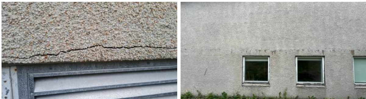
Mynd 13. B-álma þarfnast viðhalds að utan. Gluggar eru lélegir og sprungur í steiningu.
