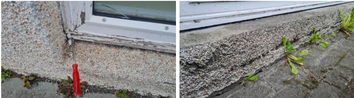
Mynd 7. Gluggar í A-álmu fara að falla á tíma og einhverjar sprungur eru í steiningu. Frágangi á kjallaravegg er ábótavant.
