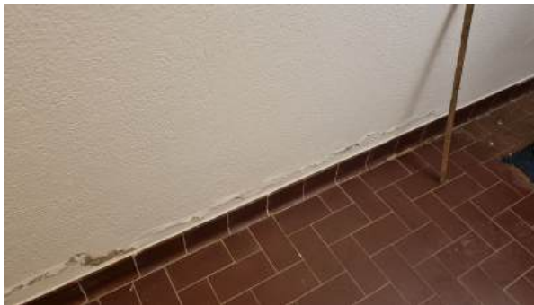
Mynd 9. Miklar rakaskemmdir eru neðan á veggjum í kjallara. Loftræsisamstæða er staðsett í rýminu.
