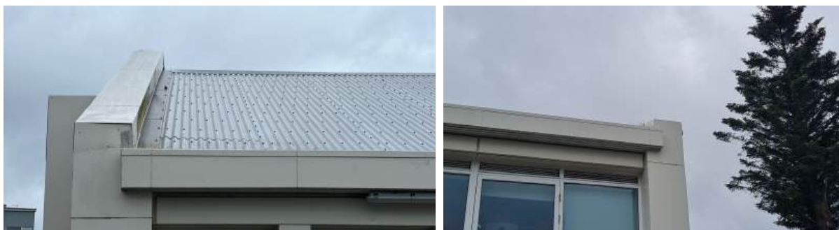
Mynd 15. Gróðurvöxtur er í þakrennu og við niðurföll og stíflar þau.
