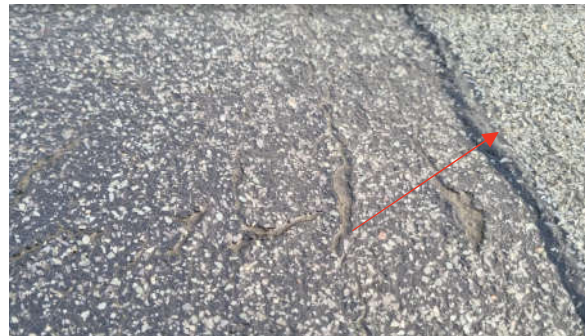
MYND 9 Nærmynd af ástandi eldri dúk. Ör vísar á nýrri dúk sem soðinn hefur verið yfir samskeyti.
