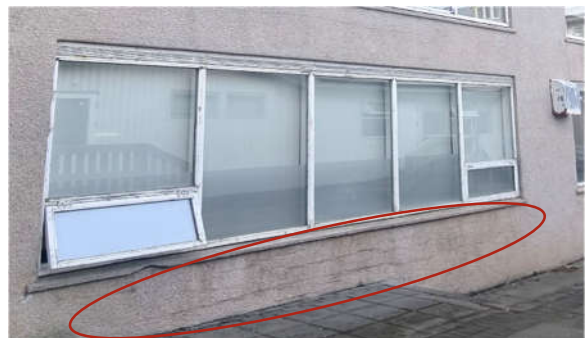
MYND 5 Sprungur fyrir neðan glugga. Sjá rauðan hring. Ekki mældist hækkaður hlutfallsraki á svæði innanhúss.
