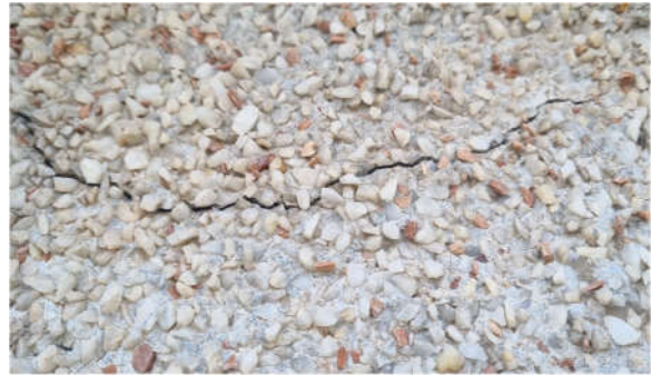
MYND 7 Dæmi um sprungur á vesturhlið og útlit steiningar. Glerbrotum er bætt í steiningarblöndu.
