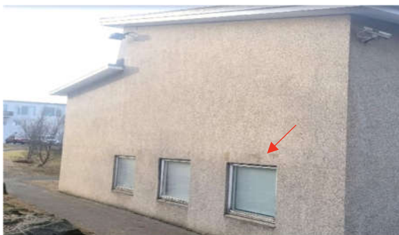
MYND 2 Austurhlið. Búið er að framkvæmda ídælingar.
