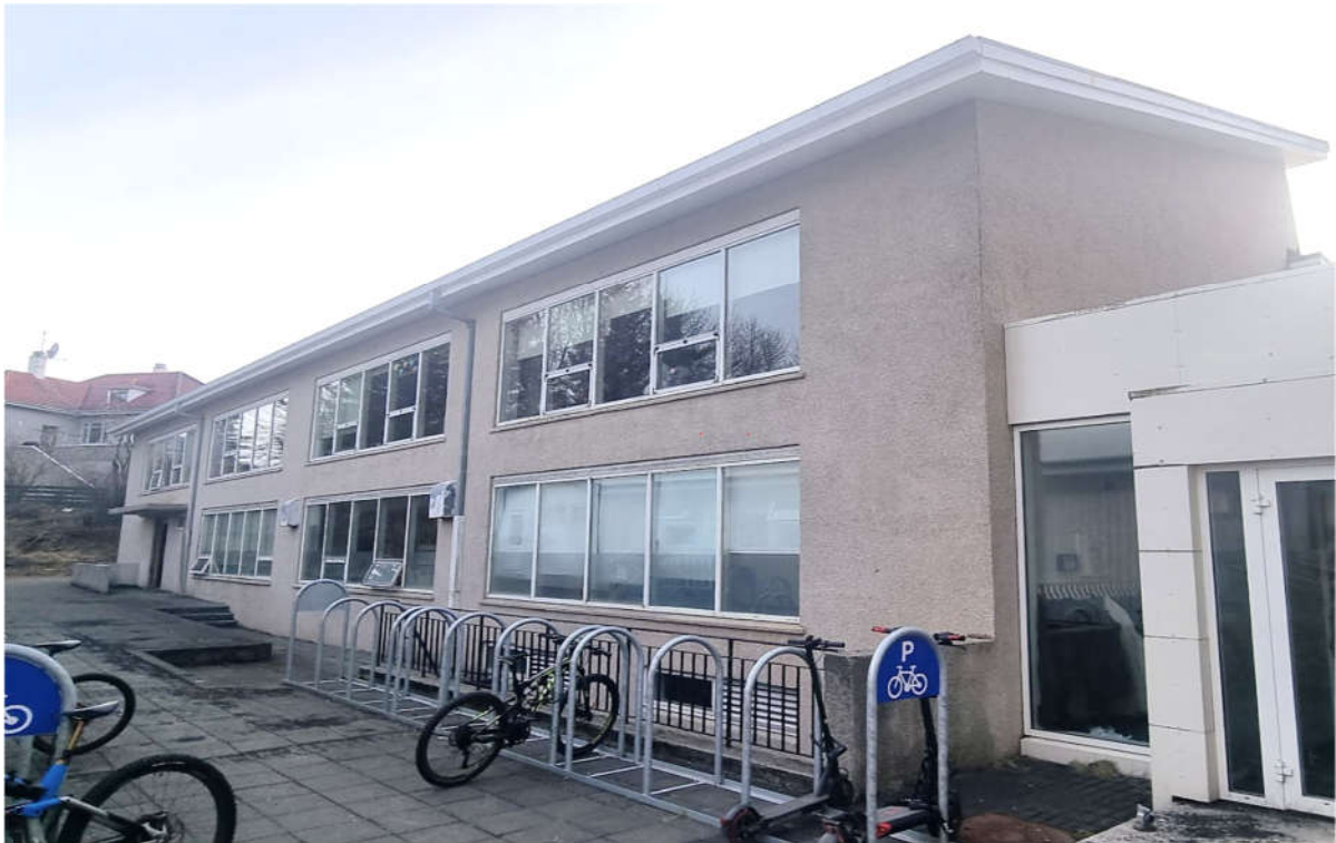
MYND 1 Norðurhlið byggingar, Álfheimaálma Langholtsskóla.
