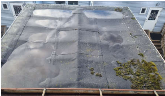
MYND 10 Ástand lápaks/stigahús. Þak afvatnar sig illa og ástand þakdúks er mjög slæmt.
