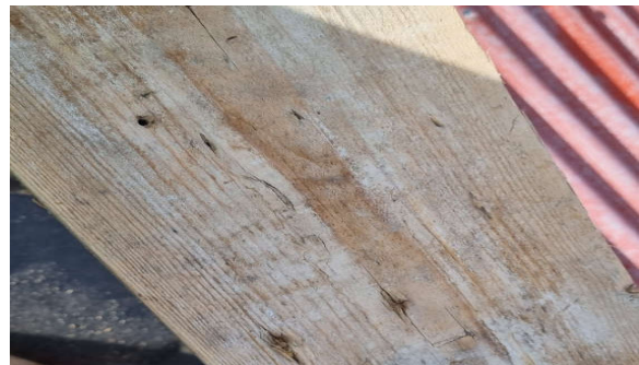
MYND 13 Innri hlið borðaklæðningar. Ummerki um rakapéttingu en engin ummerki um fúa þar sem þak var opnað.
