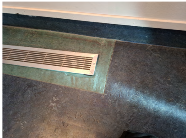
Mynd 17. Rakaskemmdir í kringum loftræstistokk
