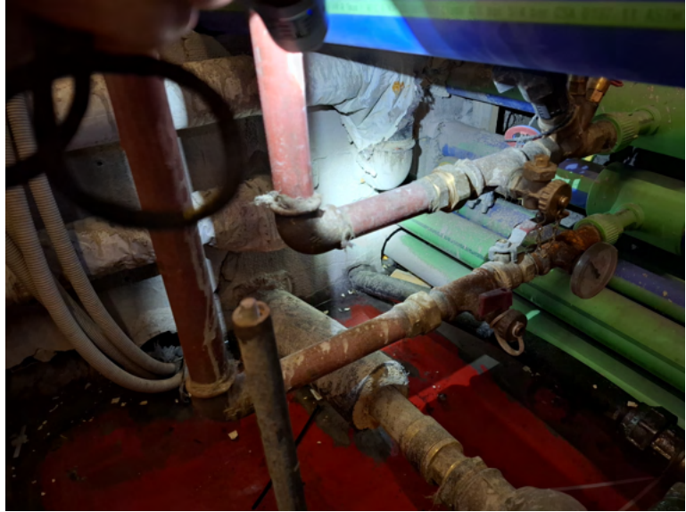
Mynd 3. Opnar lagnaleiðir við vatnsborð
