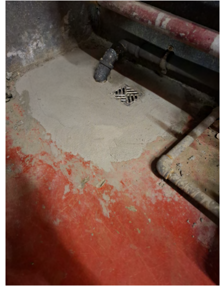
Mynd 7. Búið að opna niðurfall
