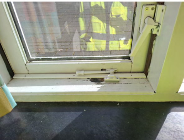
Mynd 12. Lélegur gluggi í stofu 13 1.hæð
