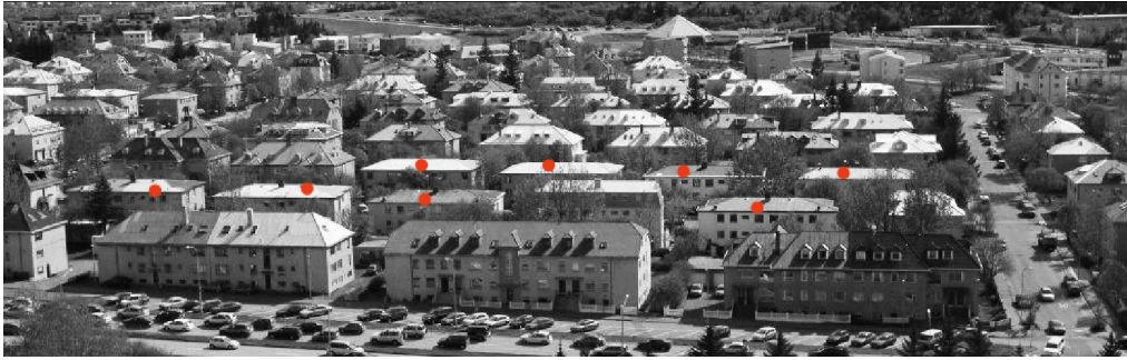
Mynd 4. Horft yfir Hlíðarnar. Húsin í Barmahlíð sem stendur til að vernda merkt með rauðum punkti.
