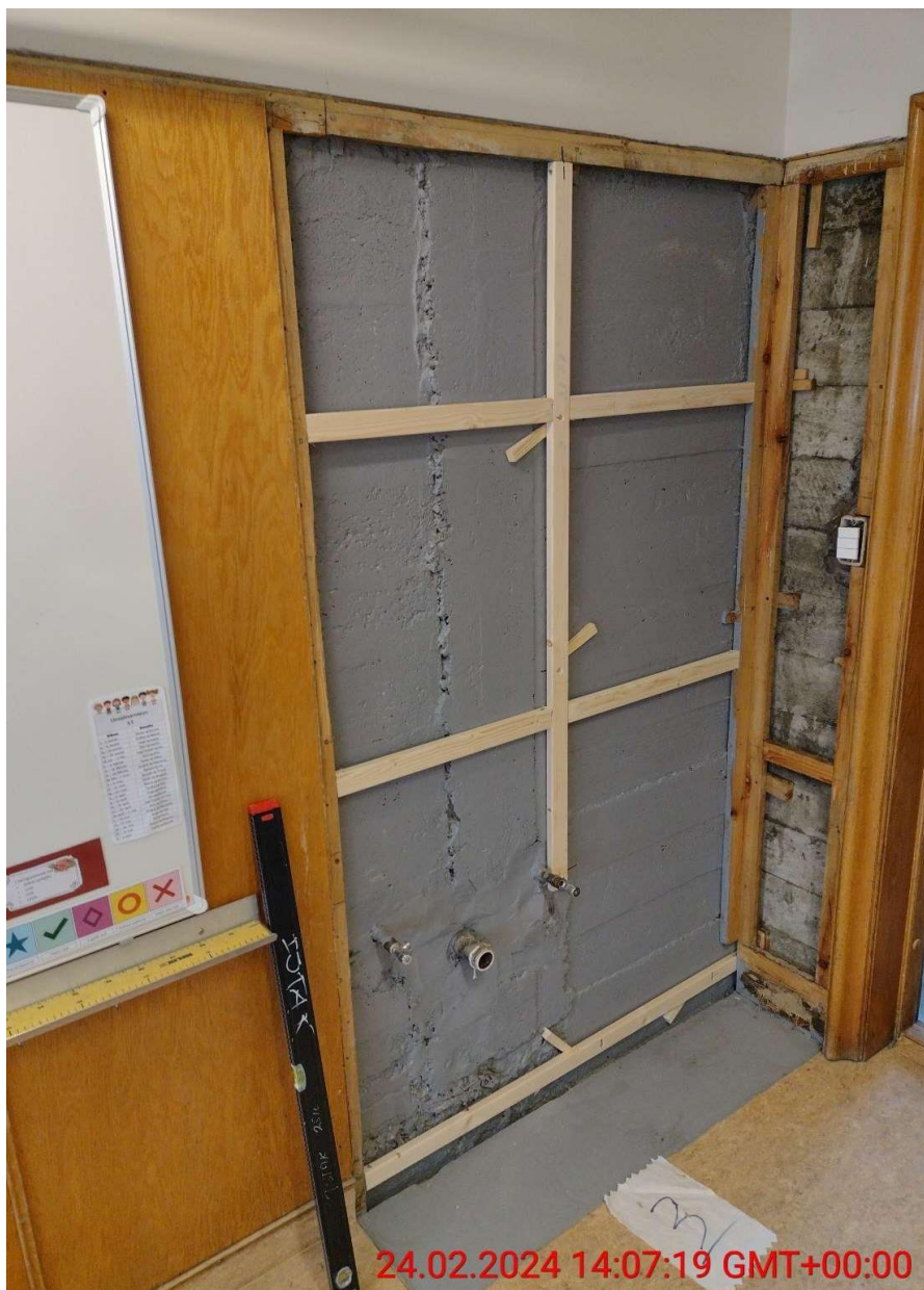
Mynd 38. Vaskasvæði í vinnslu. Laugarnesskóli 2024
