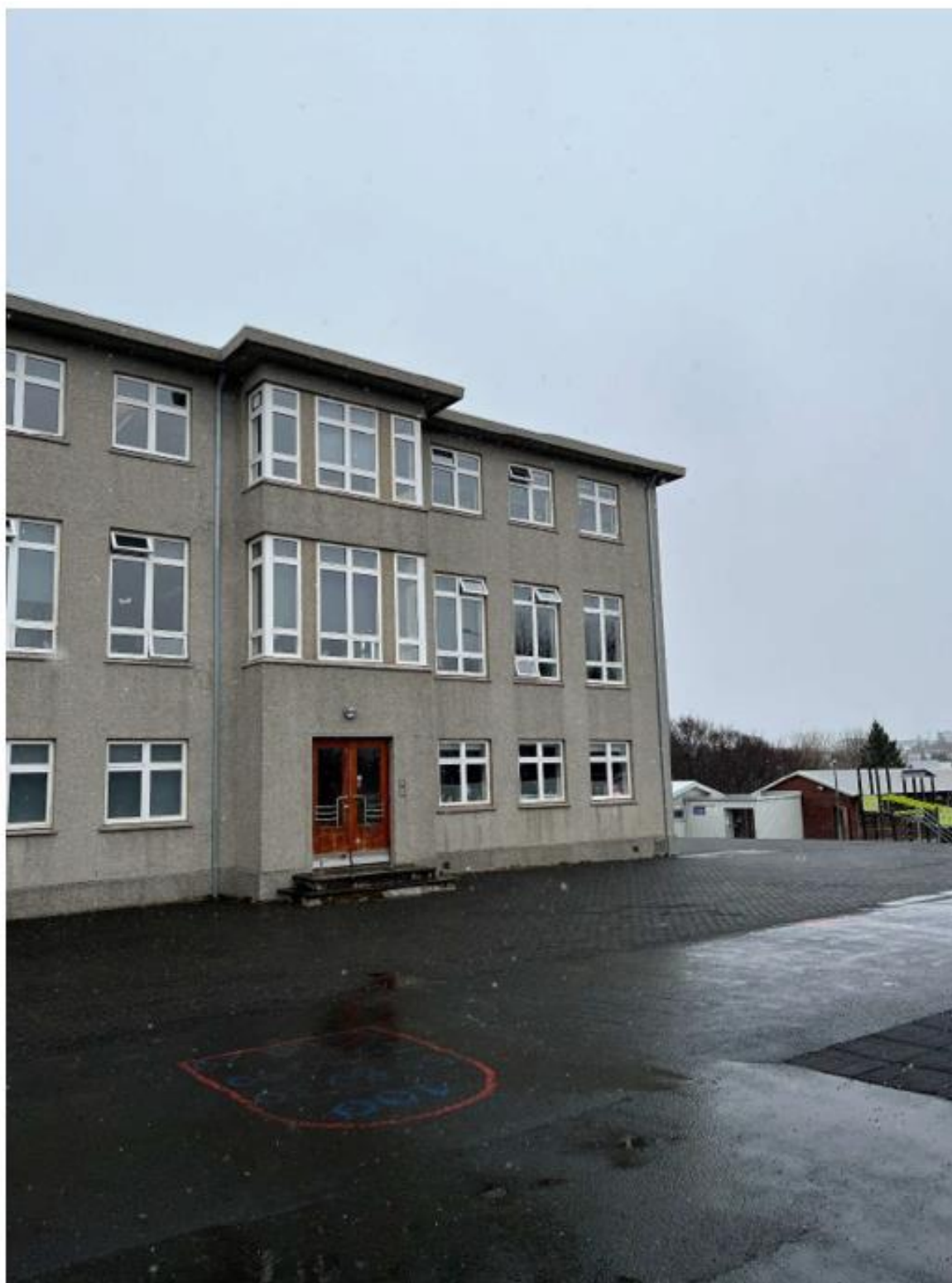
Mynd 61. Hlíð stjórnendaálmu, Fyllcoat efni borið í kringum glugga til að koma í veg fyrir leka
