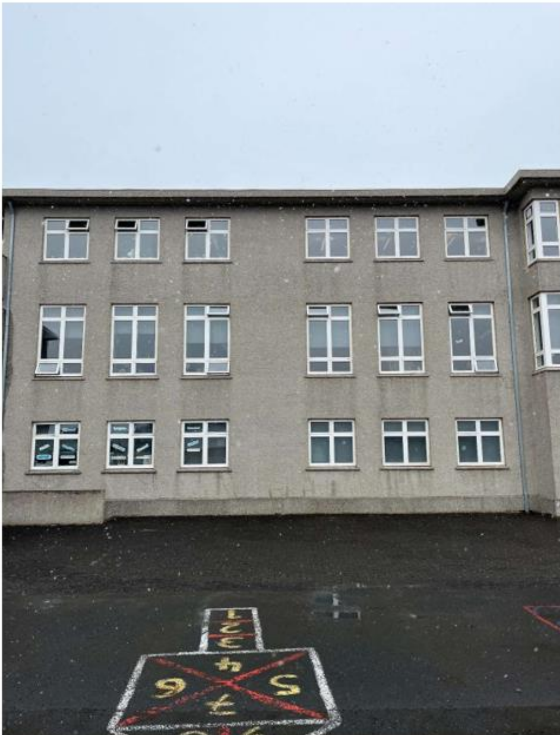
Mynd 60A. Hlið stjórnenda álmu, Fillcoat efni borið í kringum glugga til að koma í veg fyrir lek
