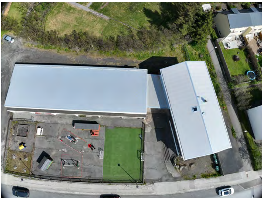
Mynd 8: Yfirlitsmynd af húsinu. Þakið nýlega uppgert.
