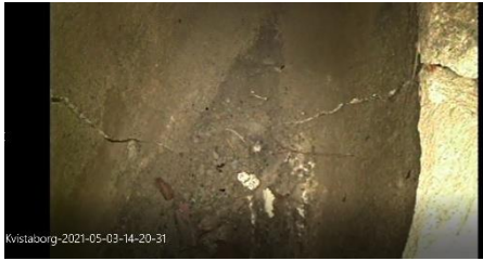
MYND 1 Drennrör brotið undir gryfju (0104)
