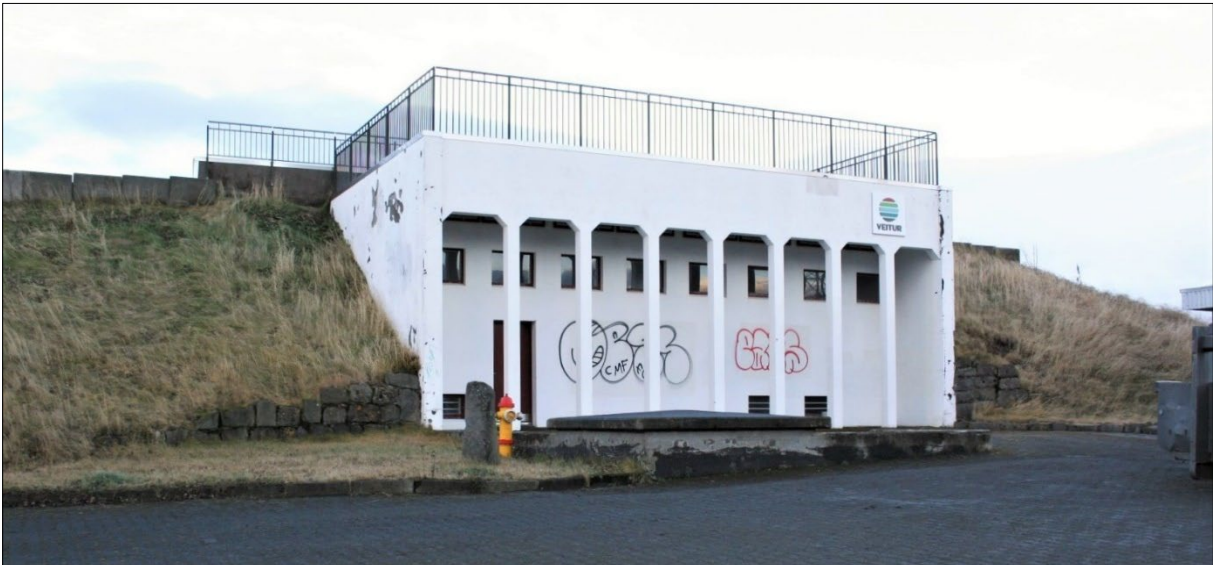
Mynd 18. Kaldavatnsgeymir á Minni-Öskjuhlíð, Bústaðavegi 7a, horft til norðurs.
