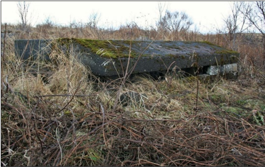
Mynd 26. Skotbyrgi (5-216) í Minni-Öskjuhlíð, horft til norðausturs.
