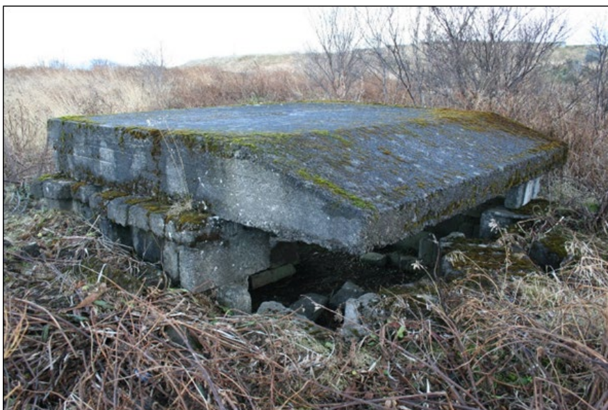
Mynd 30. Skotbyrgi (5-217) í Minni-Öskjuhlíð, horft til norðausturs að vatnsgeymi.
