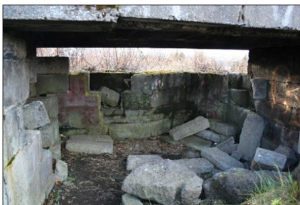
Mynd 33. Skotbyrgi (5-217), horft inn í það til suðvesturs.
