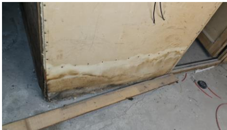
Mynd 1 Mikið rakaskemmdur krossviður í skriðkjallara undir tónlistarstofu.
