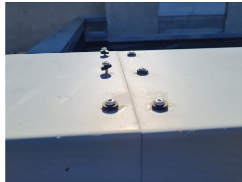
Mynd 20 Tæring í kringum skrufur sem farnar eru að losna á þakáfellum
