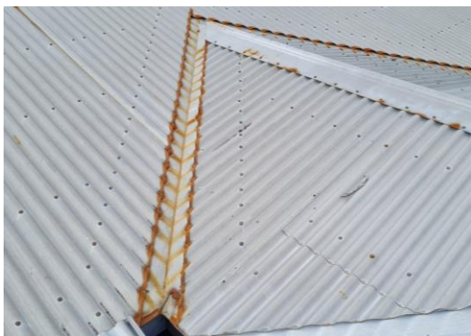
Mynd 9 Galvarisering skemmd eftir slípirokk.
