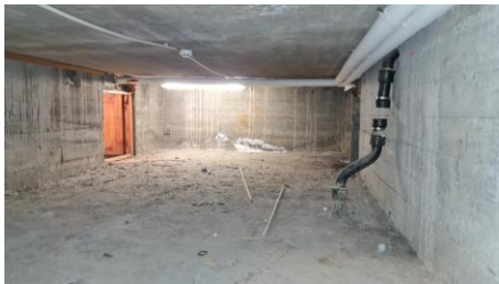
Mynd 23 Fjarlægja ætti allar aflagðar lagnir eða tryggja að ekki sé raki eða vatn í þeim.
