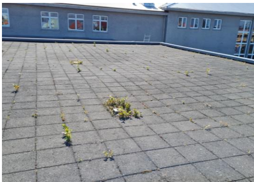
Mynd 19 Hreinsa þarf gróður af þaki og upp úr niðurföllum
