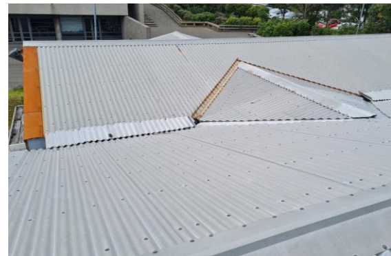
Mynd 22 Tæring á þaki frístundar
