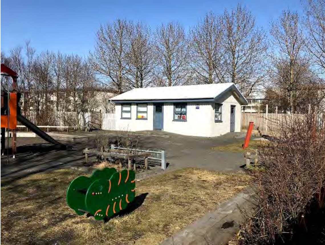
Mynd 12. Gæsluvallarhúsið á leikvöllinum sem er austan við verslunarkjarnann. 41
