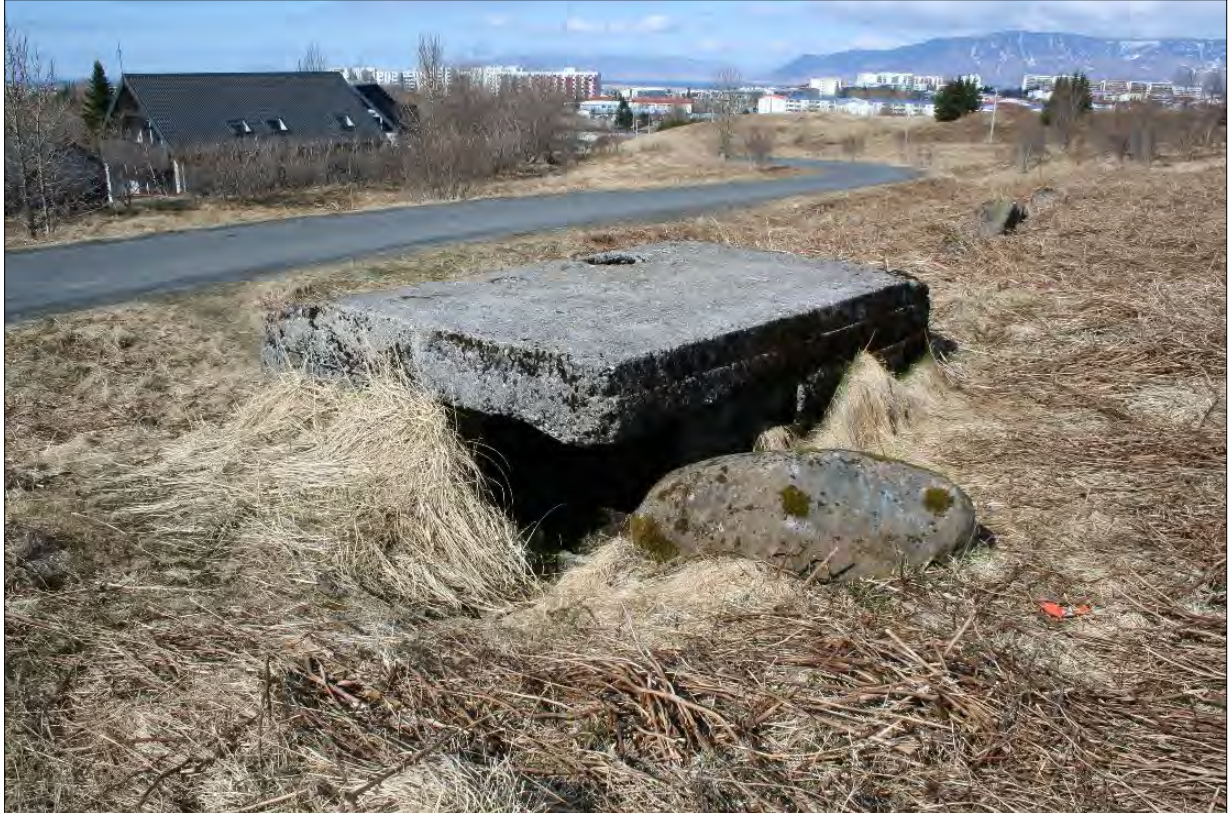
Mynd 76 Steinsteypt skotbyrgi (218-40) við Útvarpsstöðvarveg.
