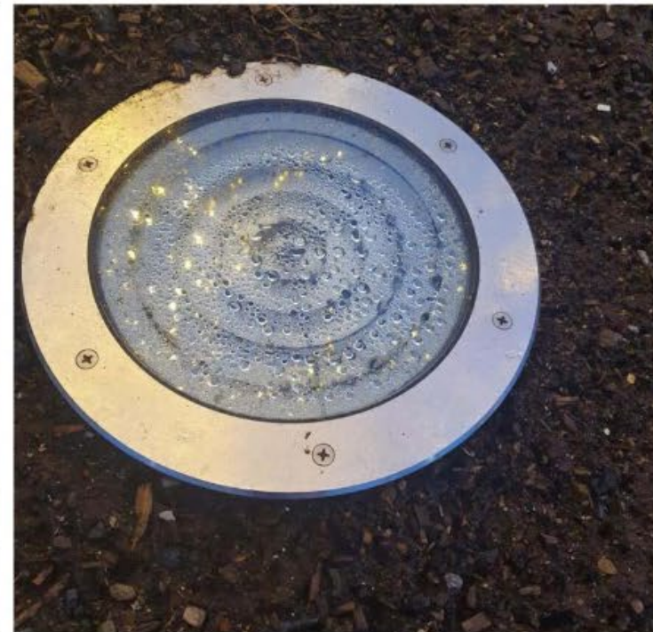
Ljósabnúnaður er kominn til ára sinna og er hluti af honum ekki lengur í virkni. Ásamt því að skyndilausnir hafa verið settar upp hér og þar sem ekki henta umhverfinu
