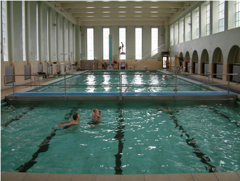
Endurbygging Sundhallar - eldra mannvirki
