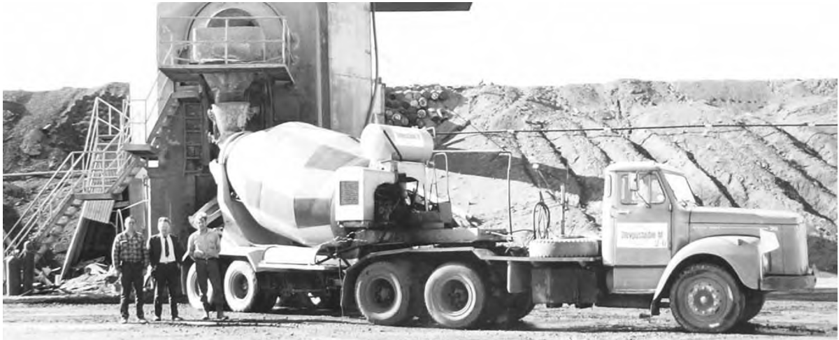
Mynd 10. Steypustöðin hóf starfsemi árið 1947 og var frumkvöðull í Evrópu í að framleiða steypu í steypubifreiðum. 38 Á myndinni má sjá matshluta 07 sem er aðflutt sænsk steypustöð (kölluð stöð nr. 2), reist árið 1964.
