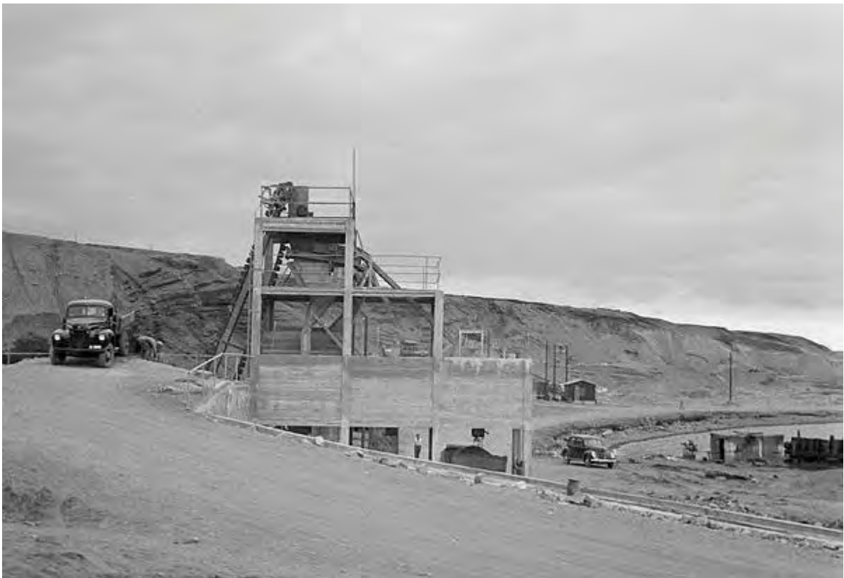
Mynd 17. Grjótmulningsvél við grjót- og sandnám Reykjavíkurbæjar árið 1944. 49
