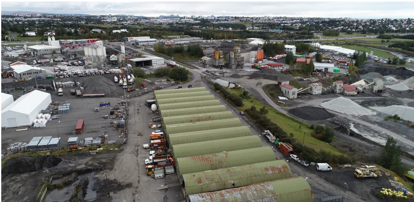
Mynd 6. Horft til suðurs yfir núverandi byggð á deiliskipulagssvæði 2
