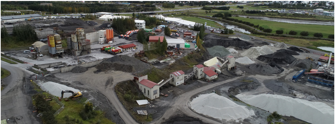
Mynd 8. Grjótmulningshús við Sævarhöfða 6-10
