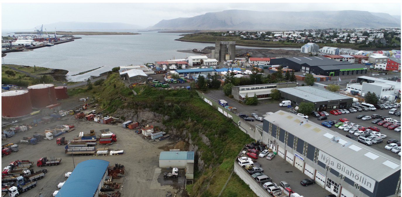
Mynd 5. Horft til norðurs yfir núverandi byggð á deiliskipulagssvæði 1
