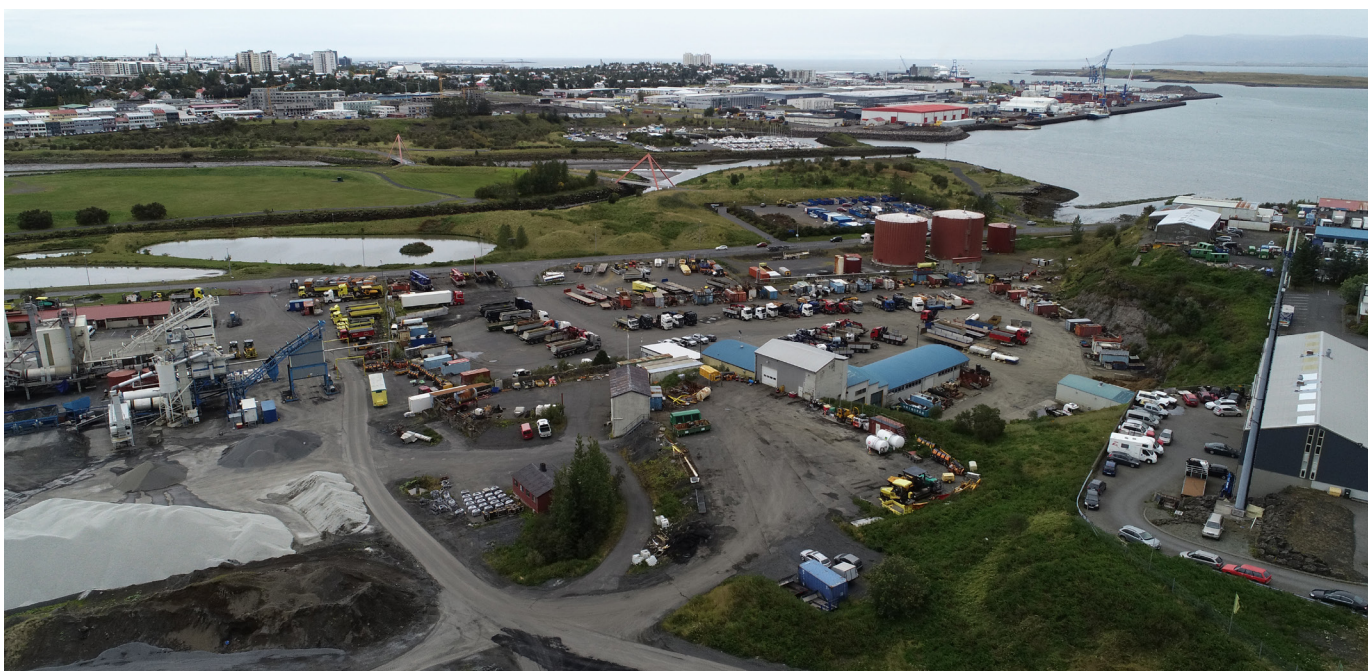
Mynd 7. Horft til norðurs yfir núverandi byggð á deiliskipulagssvæði 2
