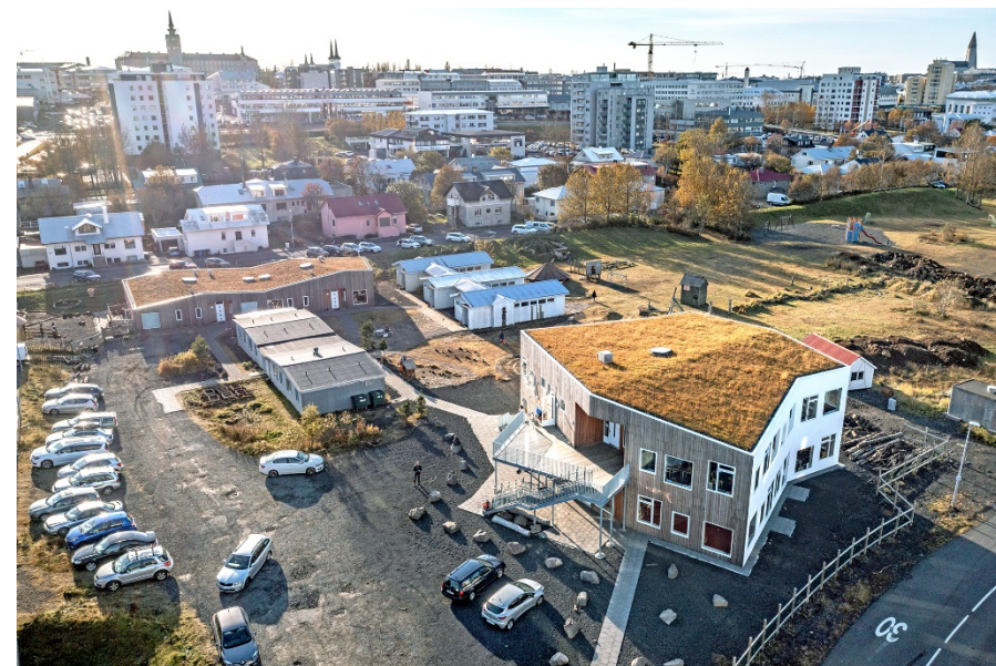
Waldorfskólinn Sólstafir í Reykjavík er úr sérhönnuðum krosslímdum timbureiningum frá Element. Umsjón með byggingu skólans hafði Mannverk ehf. en aðalhönnuðir voru Basalt arkitekta.
