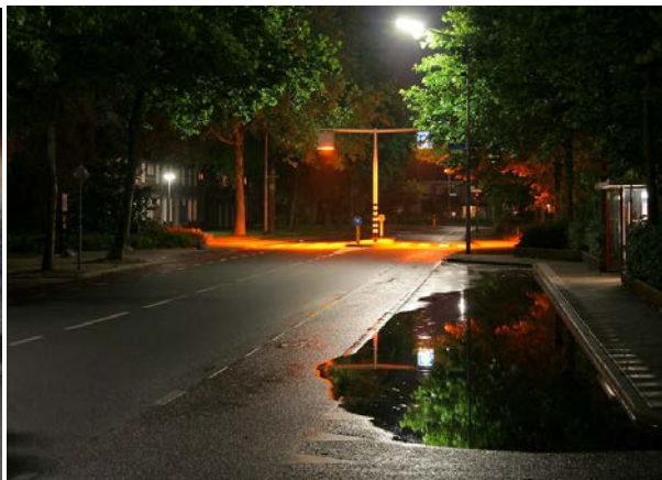
Gangbrautarlýsing í Hollandi
