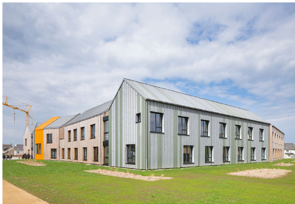
St Brieuç's Elderly Establishment Dvalarheimili aldraðra í Saint Brieuç, Frakklandi Arkitekt: Nomade Architects
