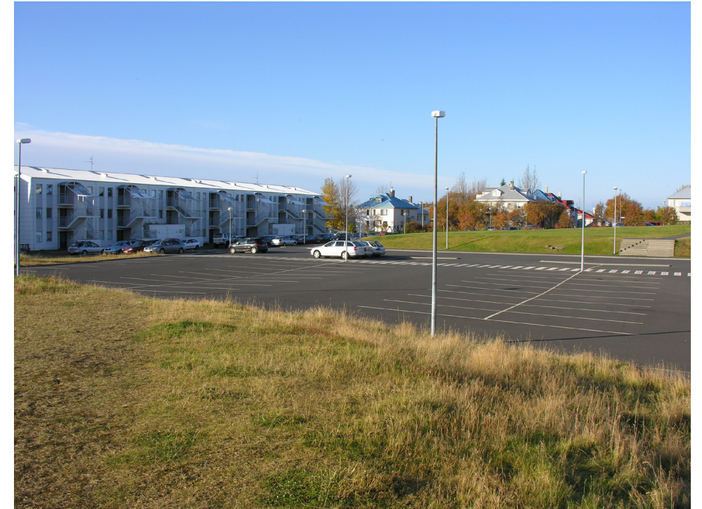
Námsmannabúðir við Bólstaðarhlíð 23
