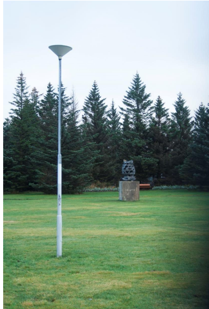
Mynd 7: Núverandi staur og lampi.
