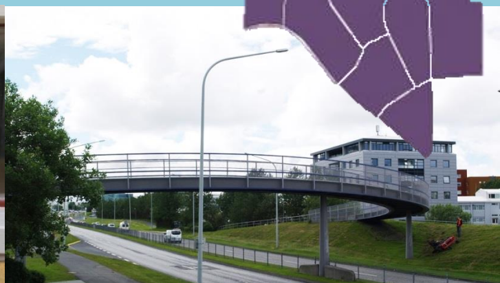
Endurnýja brúardekk á göngubrú yfir Kringlumýrarbraut
