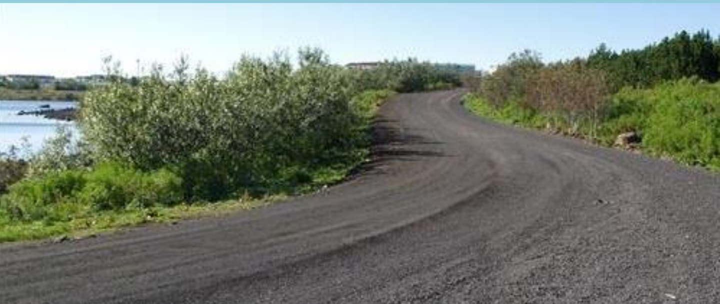
Lagfæra aðkomuveg við Rauðavatn
