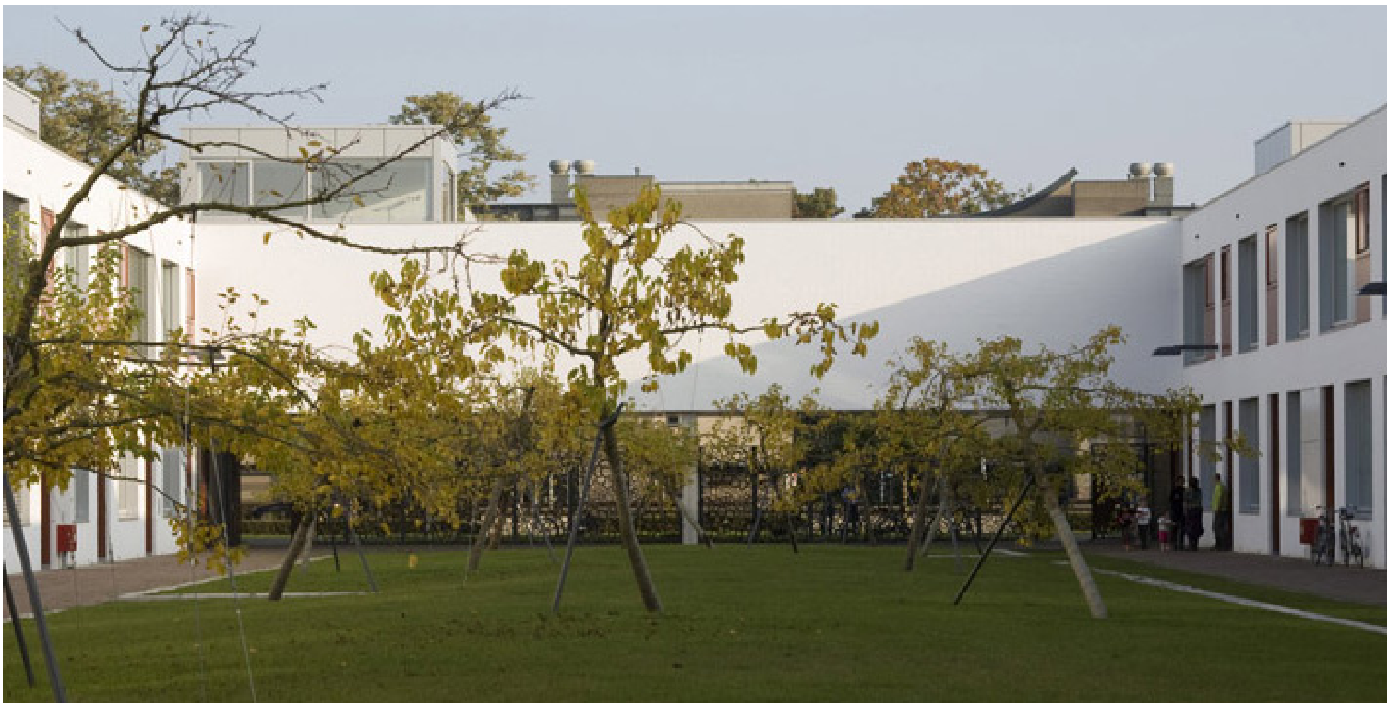
Van Sambeek & Van Veen architects, Chassé Terrein, Breda
